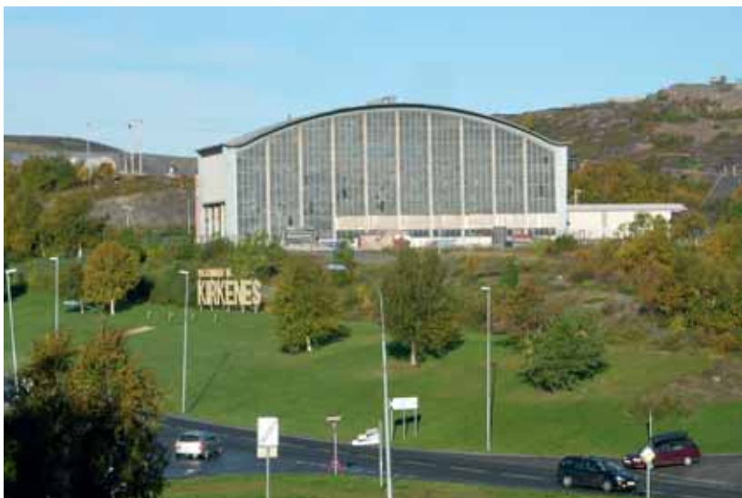
Lokhallen i Kirkenes. Frå industrilokale til kulturarena – og tilbake til industribygg. Foto: Olaf Aagedal
